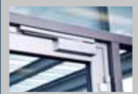
Automatic door closer
